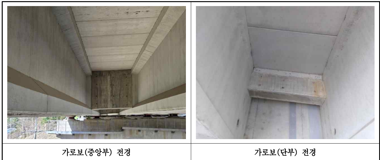
【사진 11.3.6】 가로보 전경
