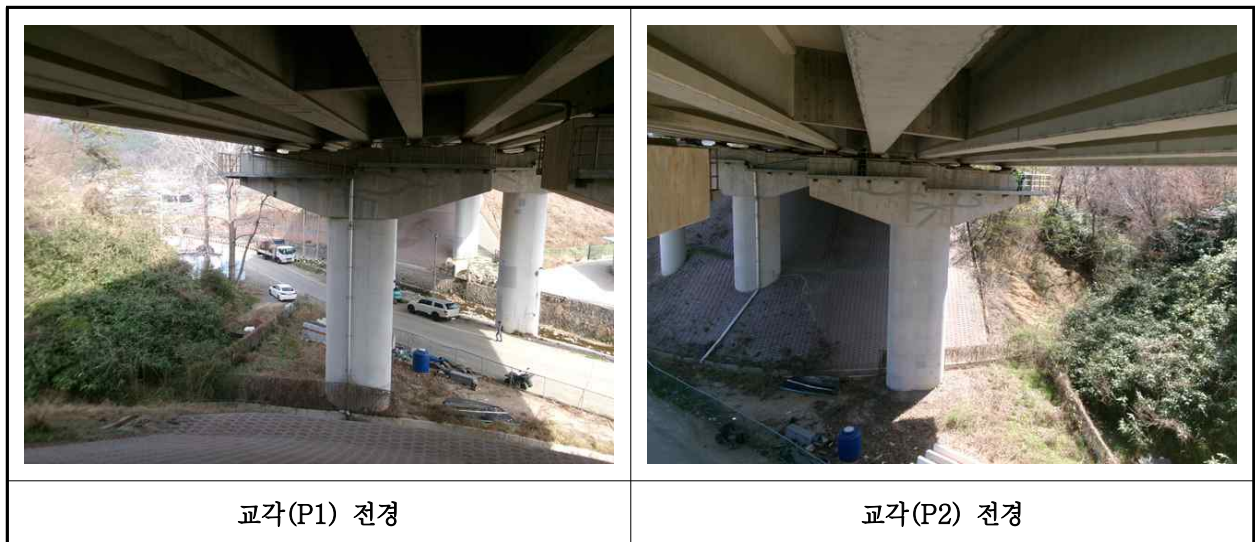
【사진 11.3.10】 교각 전경
