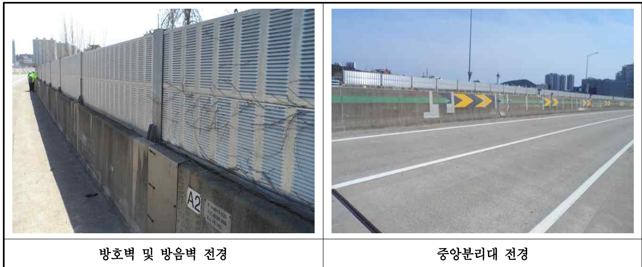
【사진 11.3.24】 방호벽 및 중분대 전경
