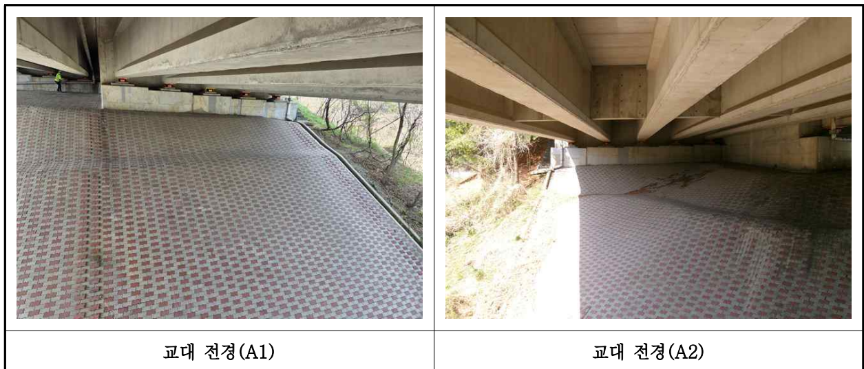
【사진 11.3.8】 교대 전경
