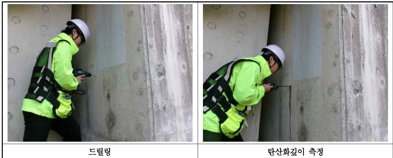
【사진 11.4.3】 탄산화 깊이 측정 현장사진
