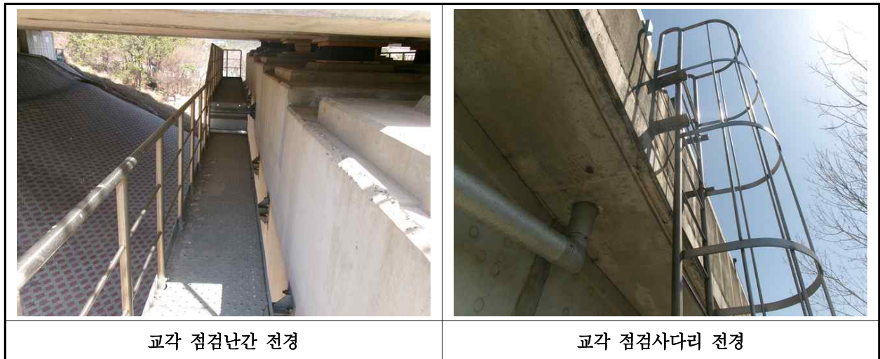
【사진 11.3.26】 교량 점검시설 전경
