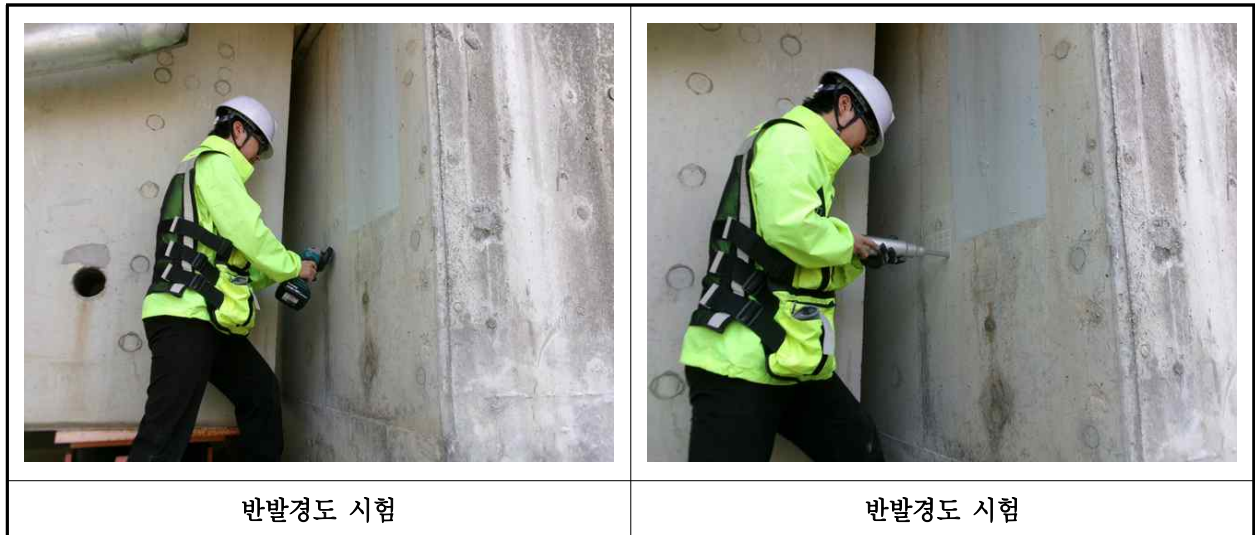
【사진 11.4.2】 반발경도시험 현장사진
