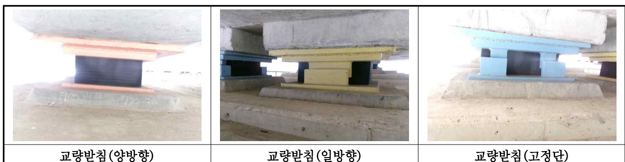
【사진 11.3.13】 교량반침 전경
