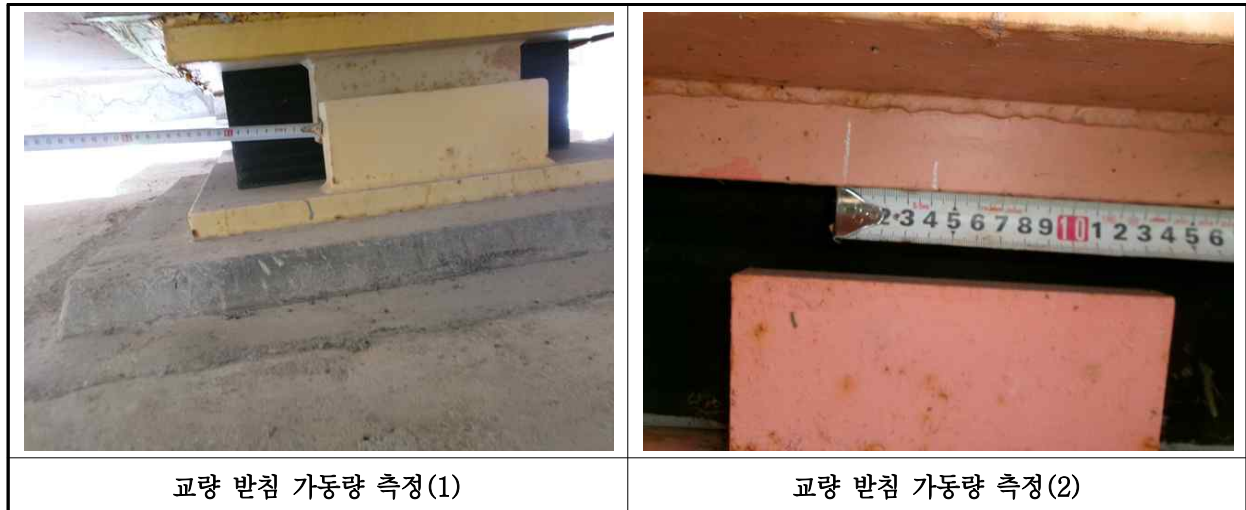
【사진 11.3.16】 교량받침 이동량 측정
