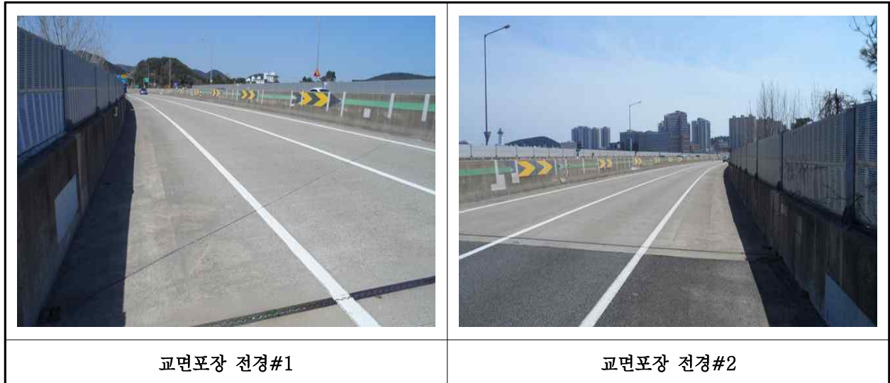
【사진 11.3.20】 교면포장 전경
