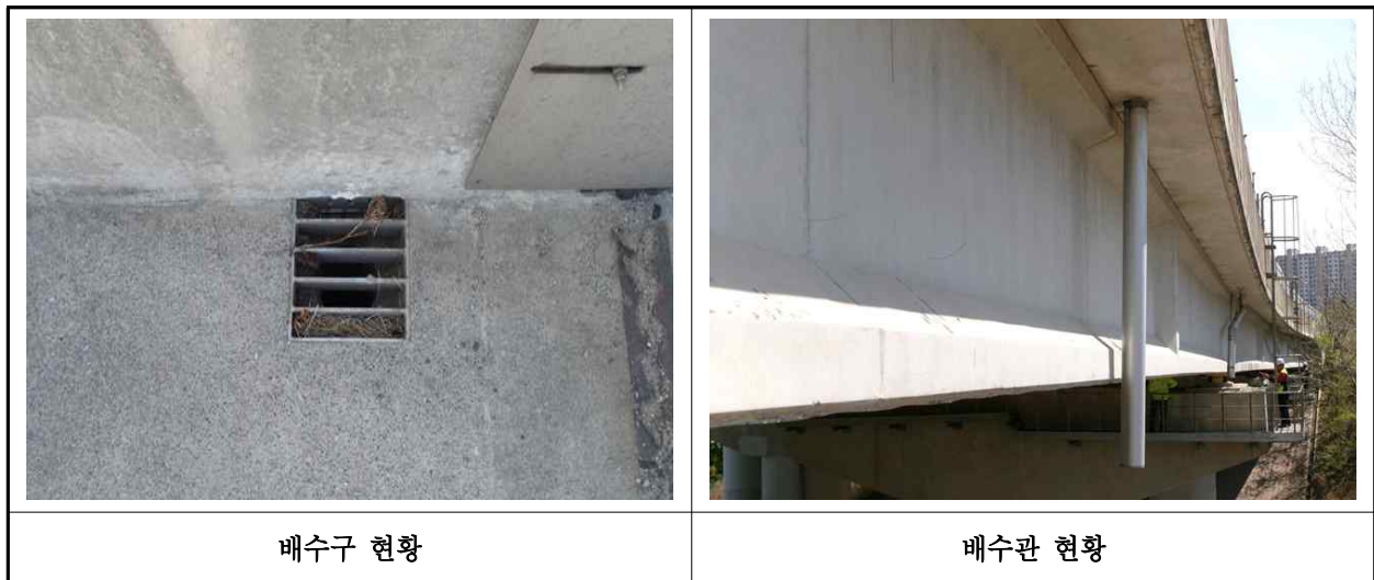
【사진 11.3.22】 배수시설 전경
