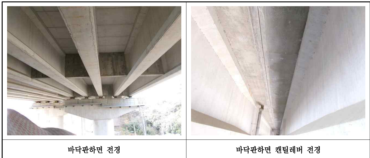
【사진 11.3.2】 바닥판하면 전경
